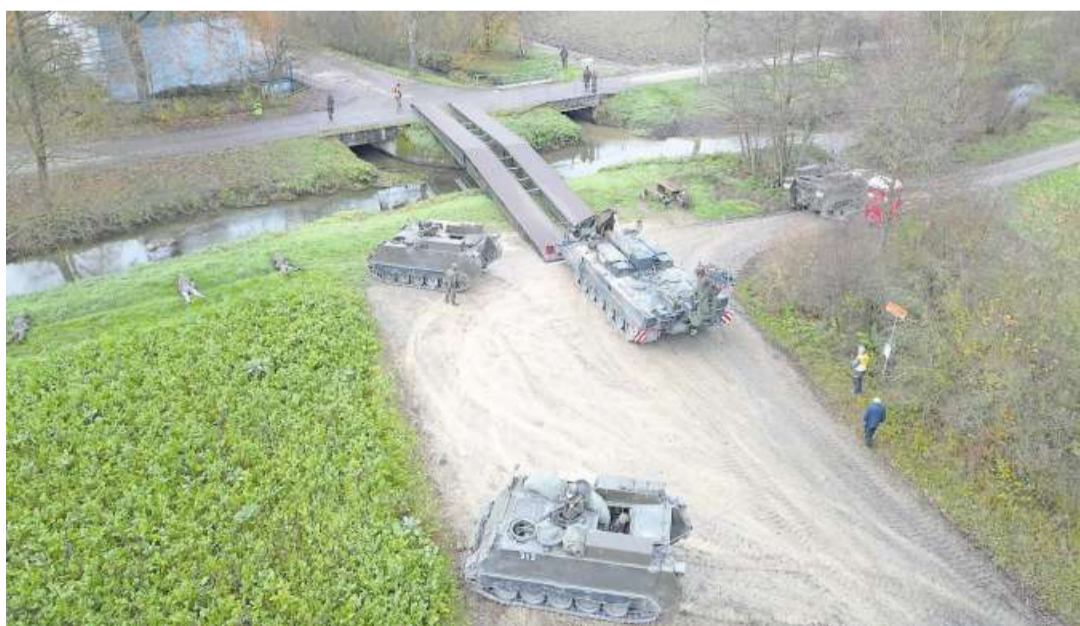
Die 26-Meter-Brücke wird über die Bünz gelegt.
